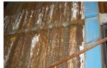
Verunreinigungen erhöhen den Druckabfall und die Energiekosten. Auch können die Platten und Dichtungen dadurch beschädigt werden.
